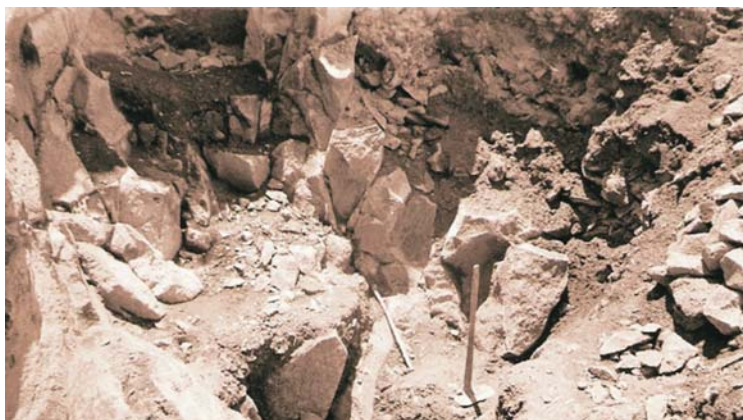
Ilustración No. 6 Azadón y piocha para extraer el material de la cantera (Referencia del Águila Flores, 1992)
